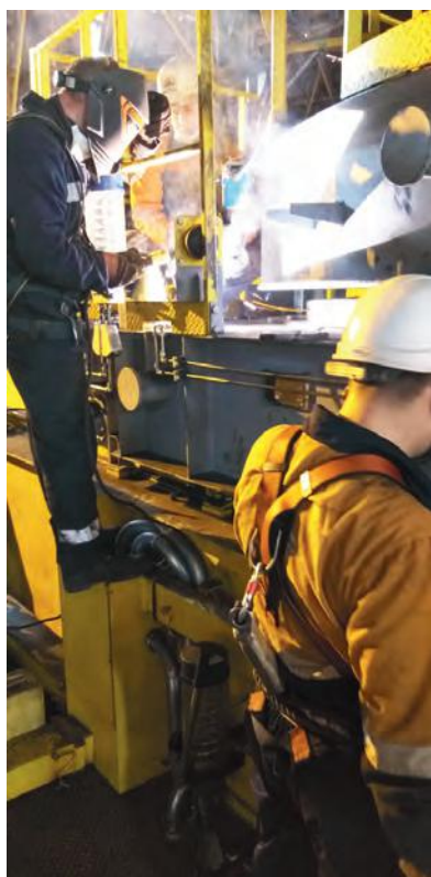
Монтажные работы на кране г/п 5+5 т
